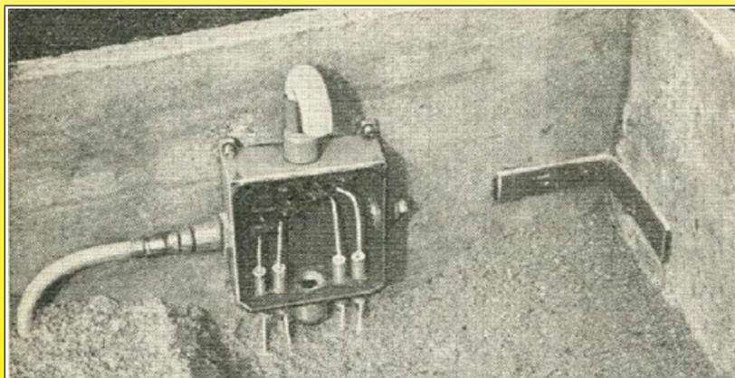
Elektrische Beheizung des Bodens, mit der Einführung von Heizkabeln
