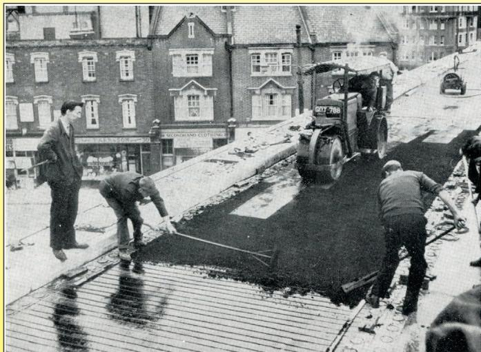
1969, Verlegung von Asphalt auf der oberen Fahrbahn einer Hammerschmidt-Kreuzung in London
